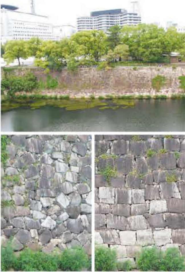
⑤55mに渡って崩れた石垣部分 ⑥修復された部分と崩れなかった部分で積み方に違いがみられる
