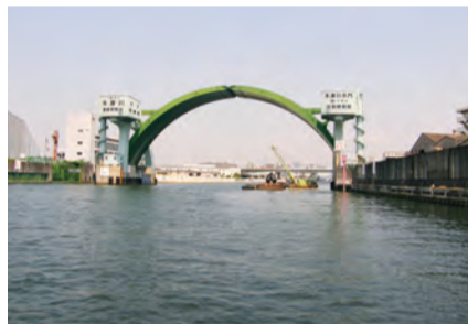
木津川河口の水門はアーチ型の部分が向こう側に倒れて、大阪市街を津波や高潮被害から守ってくれる（撮影・中条武司氏）
