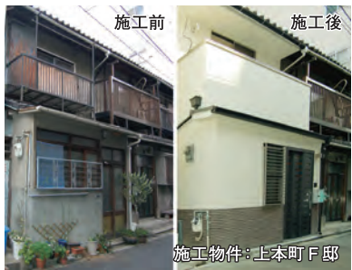
施工前 施工後 施工物件:上本町F邸
