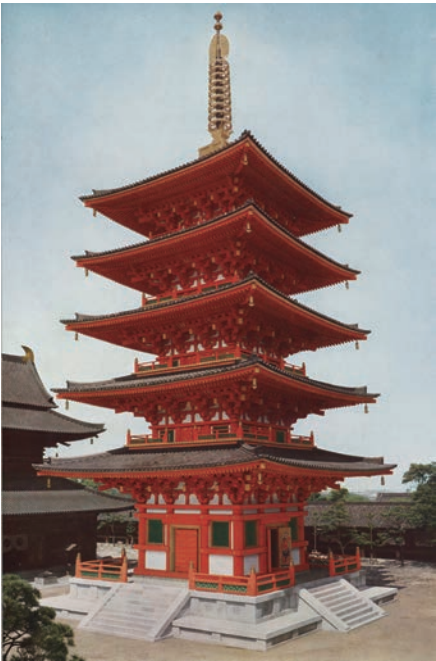
昭和再建五重塔
