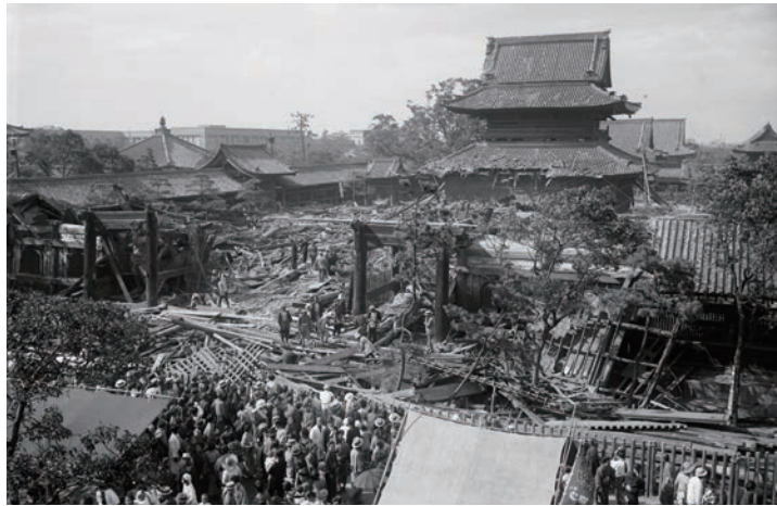
倒壊した中門と五重塔
