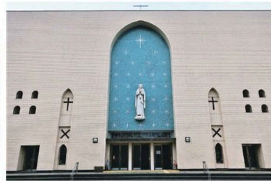
現在の建物は1963年に完成
